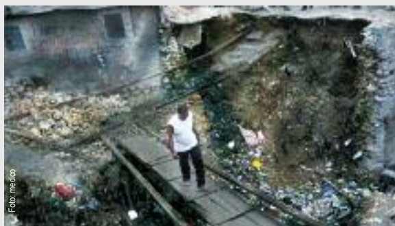
Provisorischer Steg in der Cité 9, Port au Prince. Eine neue Brücke wird oberhalb des Stegs auf Straßenniveau gebaut (siehe S. 4).
