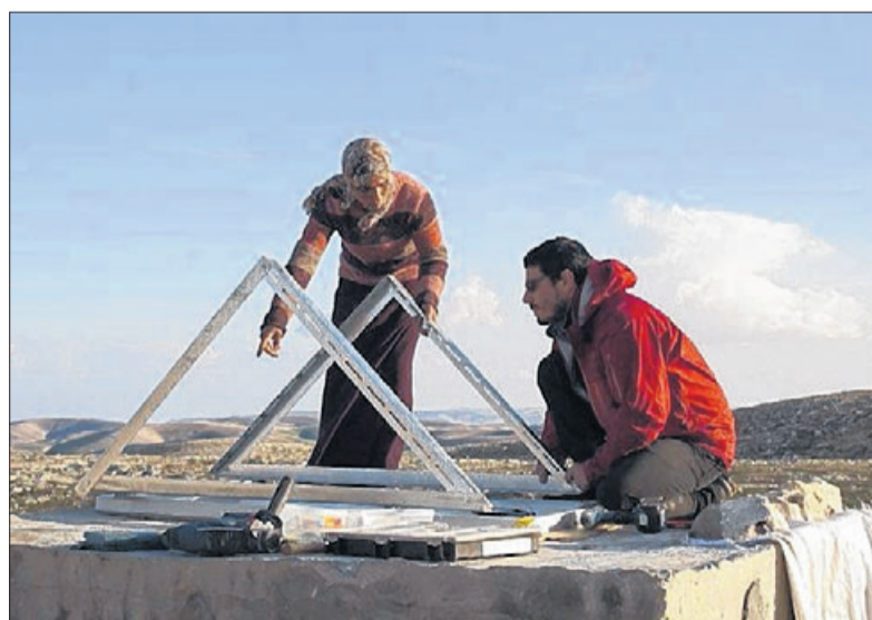
Die Grundlagen sind gelegt: Ingenieure errichten die Basis für neue Sonnenkollektoren in Dörfern südlich von Hebron. Doch das gefällt nicht jedem. Privatfoto
