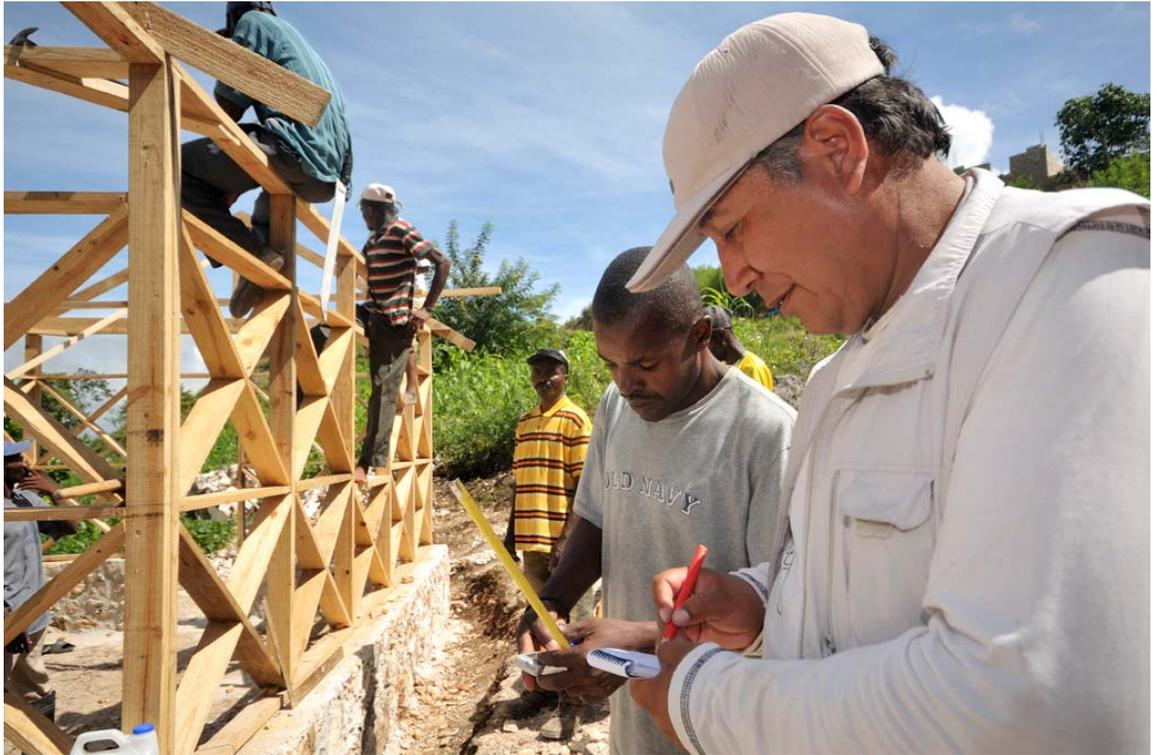
*Aufbau auf dem Land: Wilfredo Carazas, Architekt und Misereor-Berater, unterrichtet lokale Bauarbeiter in erdbebensicherem Hausbau. Foto: Misereor*
