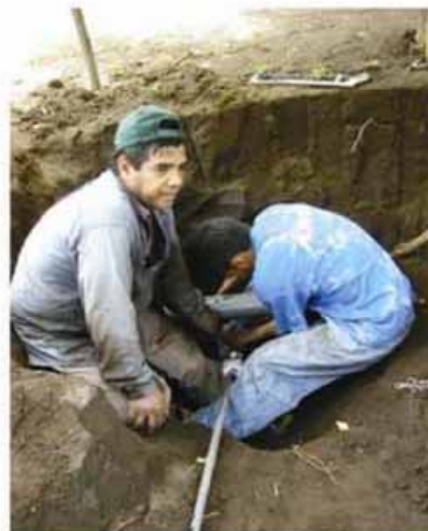
Conectando agua potable
