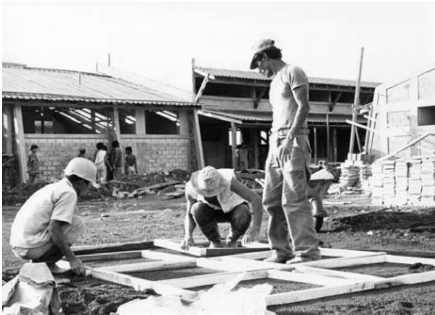
Nicaragua, San Carlos: Krankenhausbau
